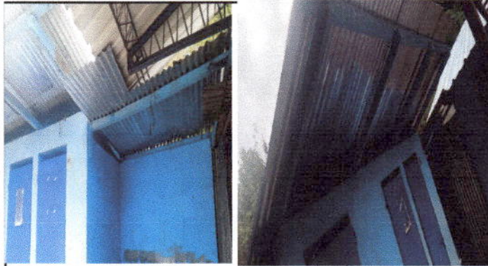
Foto 1: CUBIERTA DE LÁMINA: sustitución de lámina, por lámina troquelada aluzinc calibre 26, MÓDULO 1.
