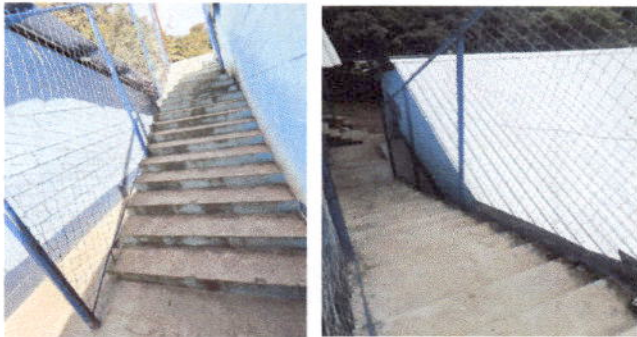
Foto 7: MANTENIMIENTO A BARANDAS: Sustitución de barandas de metal po tubo preceso, MÓDULO 1
