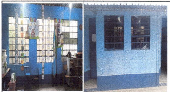
Foto 4: VENTANAS: Sustitución de estructura de metal de ventana por PVC y balcones de metal, MÓDULO 1
