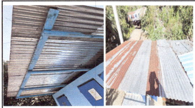
Foto 2: ESTRUCTURA DE TECHO: Sustitución de soporte de madera, por metal, MÓDULO 1
