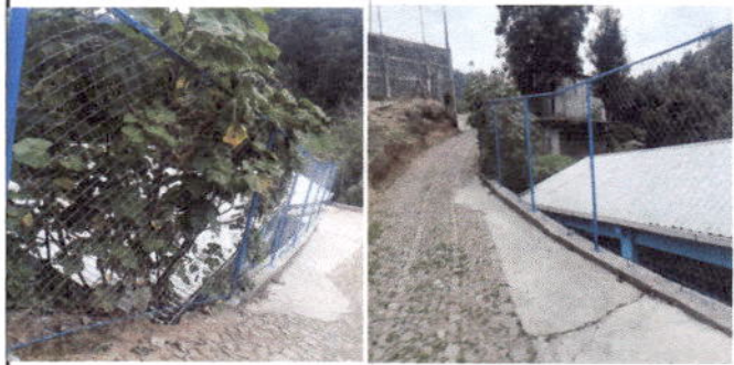
Foto 8: MANTENIMIENTO A BARANDAS: Sustitución de barandas de metal po tubo preceso, MÓDULO 1
